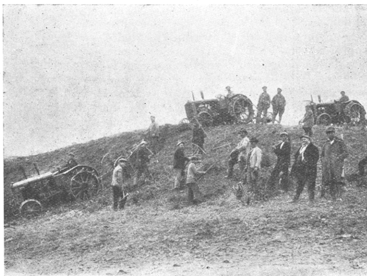
Masseria Capotosto - Lavori di dissodamento
