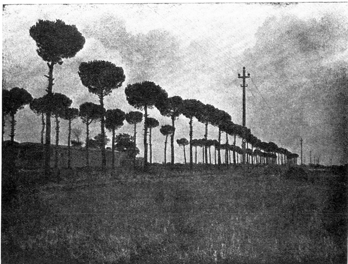
SOCIETÀ GENERALE PUGLIESE DI ELETTRICITÀ: Linea Foggia-Manfredonia
