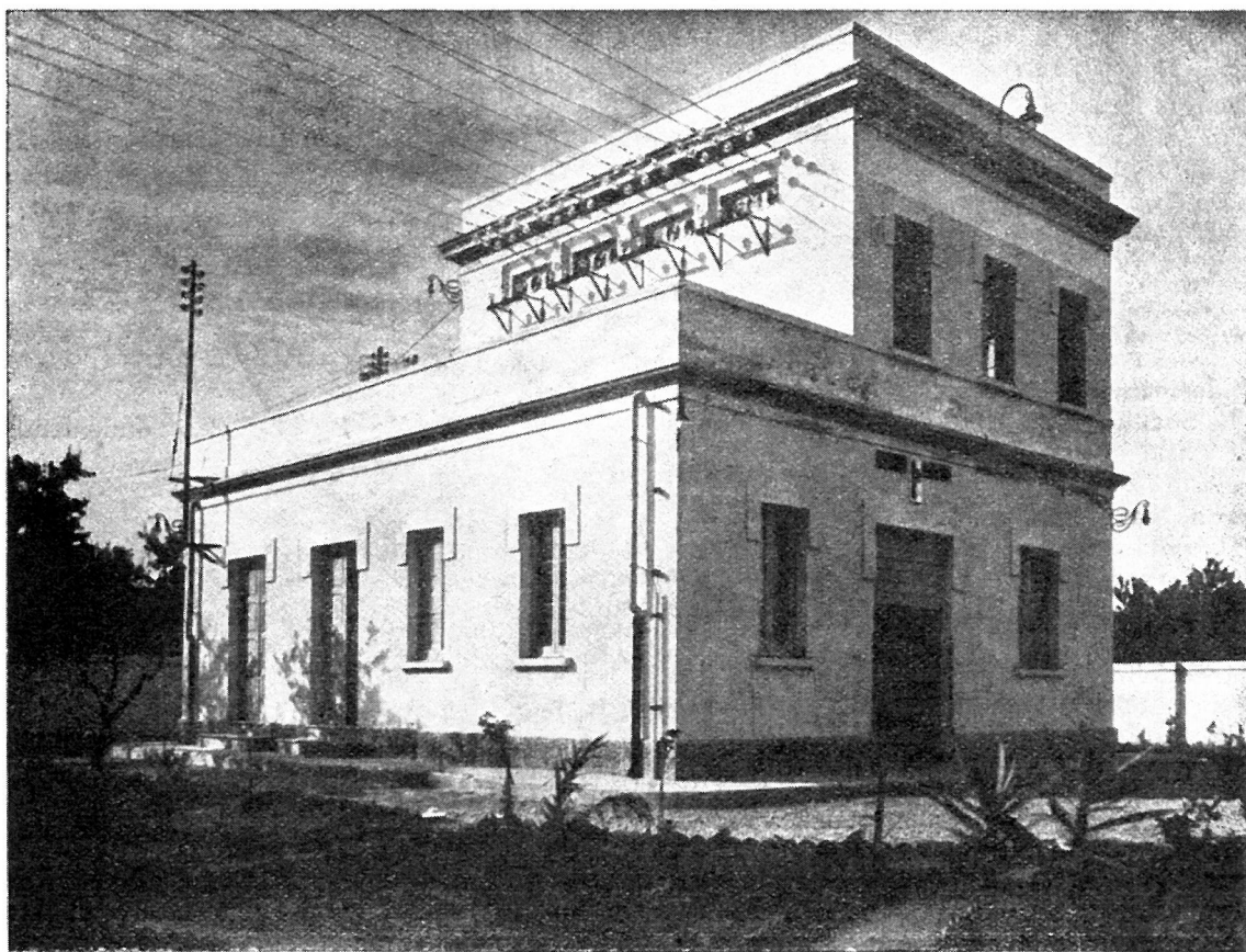
SOCIETÀ GENERALE PUGLIESE DI ELETTICITÀ: Sottostazione di Brindisi
