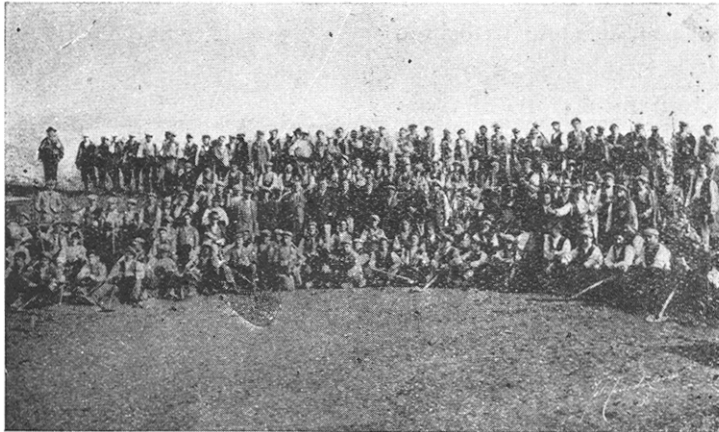
Maestranze dell'azienda « V. Dinnella », adibite in lavori per la bonifica del Locone
