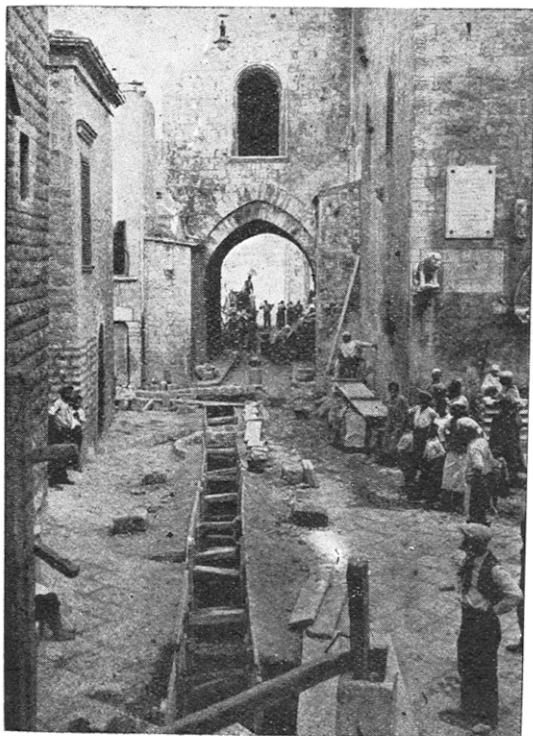
Barletta - Fognatura in una vecchia strada monumentale
