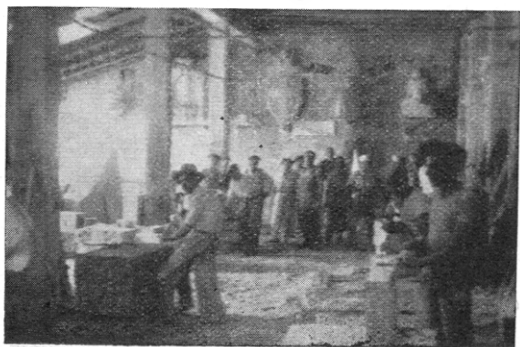
Ditta Bassi: Lavorazione della pietra di Trani
