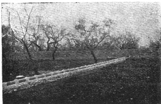
Canale per la distribuzione dell'acqua depurata
